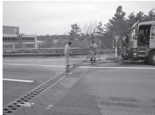
写真一10 遊間に設置された樋の清掃 (スイス)
