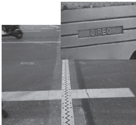
写真一1 アルミニウム製ジョイント（フランス）
