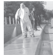
写真-7 塗膜系およびシート系防水システムの施工例
