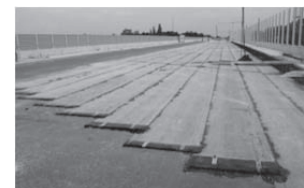
写真-7 塗膜系およびシート系防水システムの施工例
