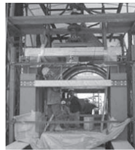
写真-5 振動下での吹付け試験
