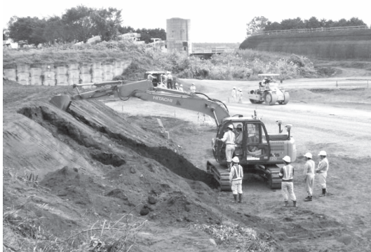
写真-1 MG油圧ショベルの実習状況
