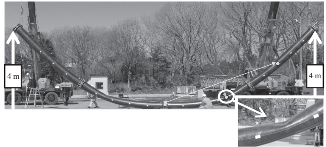
写真一 3 高密度ポリエチレン管の曲げ試験状況
