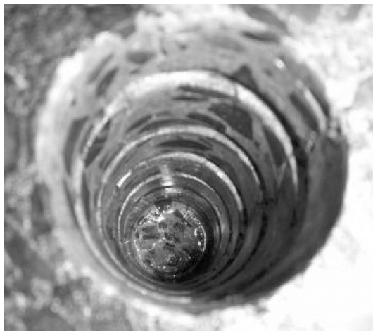
写真-2 溝切削後の孔内
