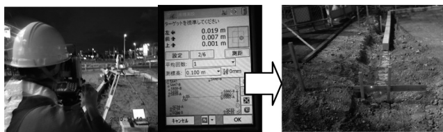
図-7 出来形管理用TSを用いた丁張り設置状況
