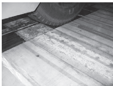
写真-2 ユニットのボルト添接部
