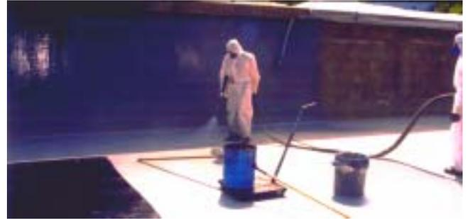
写真1 吹付けによる橋面への防水層の施工
