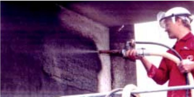
写真—2 ショットクリートによる断面修復
