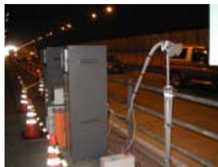
写真-2 対策前の歩道部上での環境計測
