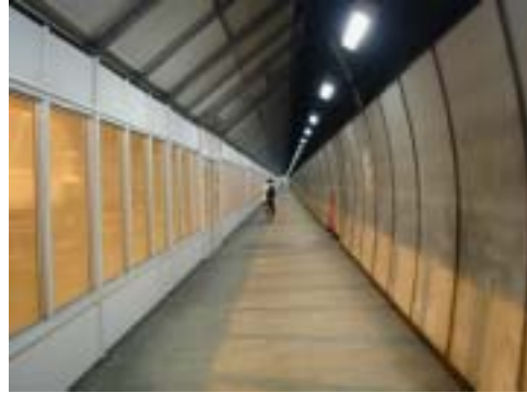
写真 - 5 対策工完成後のトンネル内歩道部
