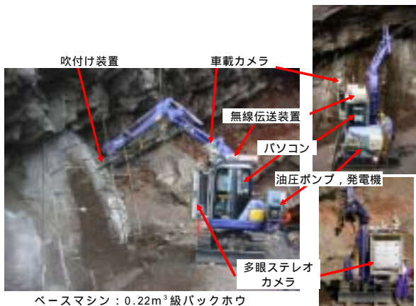
写真 - 2 吹付けロボットの機械構成
