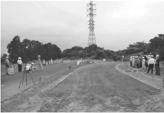
写真一 4 TLS計測時（舗装面）
