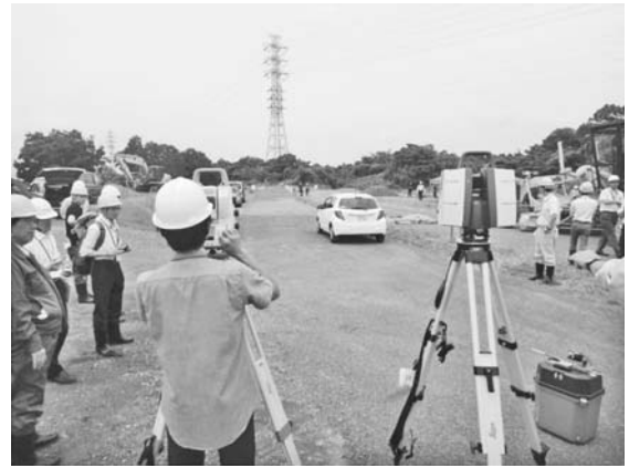
写真-1 TLS計測時(起工面)
